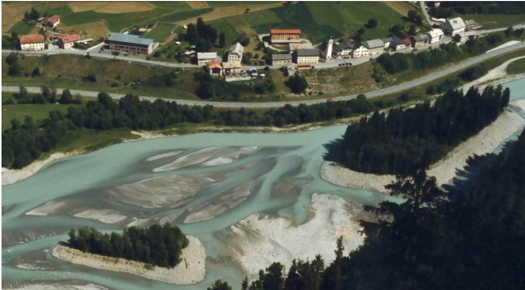
(Foto: Tiefbauamt GR)
